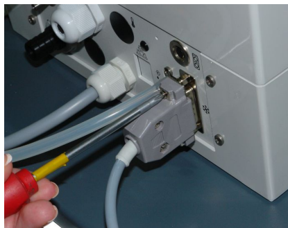
断开分析仪和气体干燥器之间的电源线.
